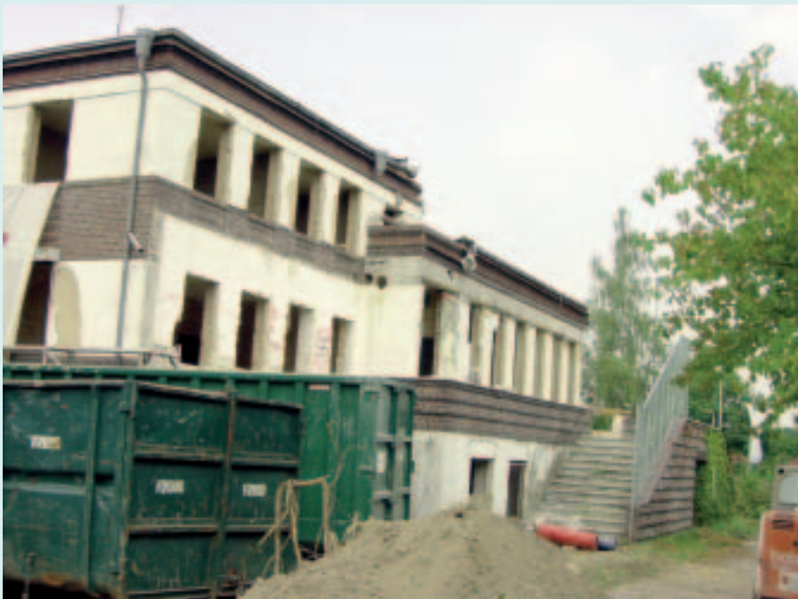
Blick auf das Waldschwimmbad während der Renovierungsphase. Rechts die Freitreppe die in dieser Form als Einzelteil erhalten bleibt.
